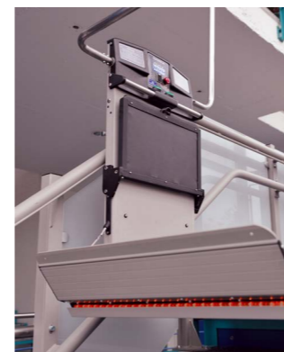
Czujniki bezpieczeństwa chronią innych użytkowników schodów
